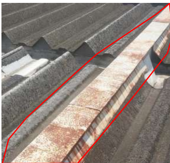
Foto 01-Detalhe do cobre muro
